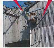
高圧変圧器 高圧コンデンサー
